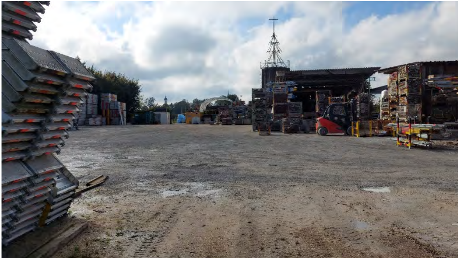
Abb. 8: Gerüstbau Hander von Norden.
