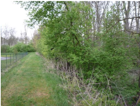
Foto 3: Damm um die ganze Kläranlage (hier der Nordrand).
