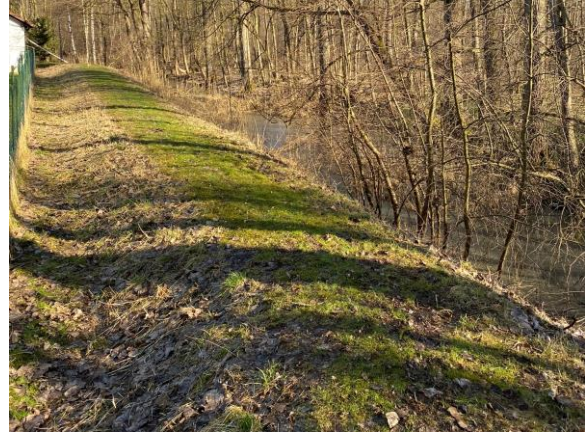
Abbildung 11: Bestehender Damm und Klärgraben südöstlich der Anlage. Aufnahme 14.02.2021
