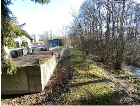
Abbildung 10: Bestehender Damm und Klärgraben südlich der Anlage. Aufnahme 14.02.2021.
