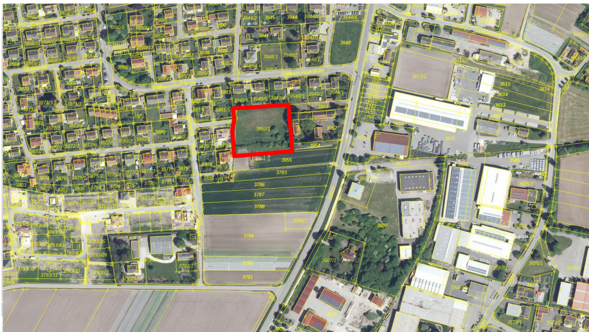
Abb. 1: Luftbild vom Plangebiet (Befliegungsdatum: 15.05.2022) mit Geltungsbereich des Bebauungsplans (rot umrandet), o.M. (© 2024 Bayerische Vermessungsverwaltung)
