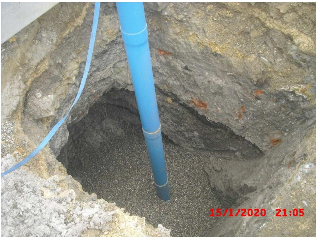
Abb. 4: Schurf S8, Einstellen von 1 m Filterrohr und 3 m Vollrohr, Hinterfüllung mit Kies im Filterbereich von 3-4 m u. GOK.
