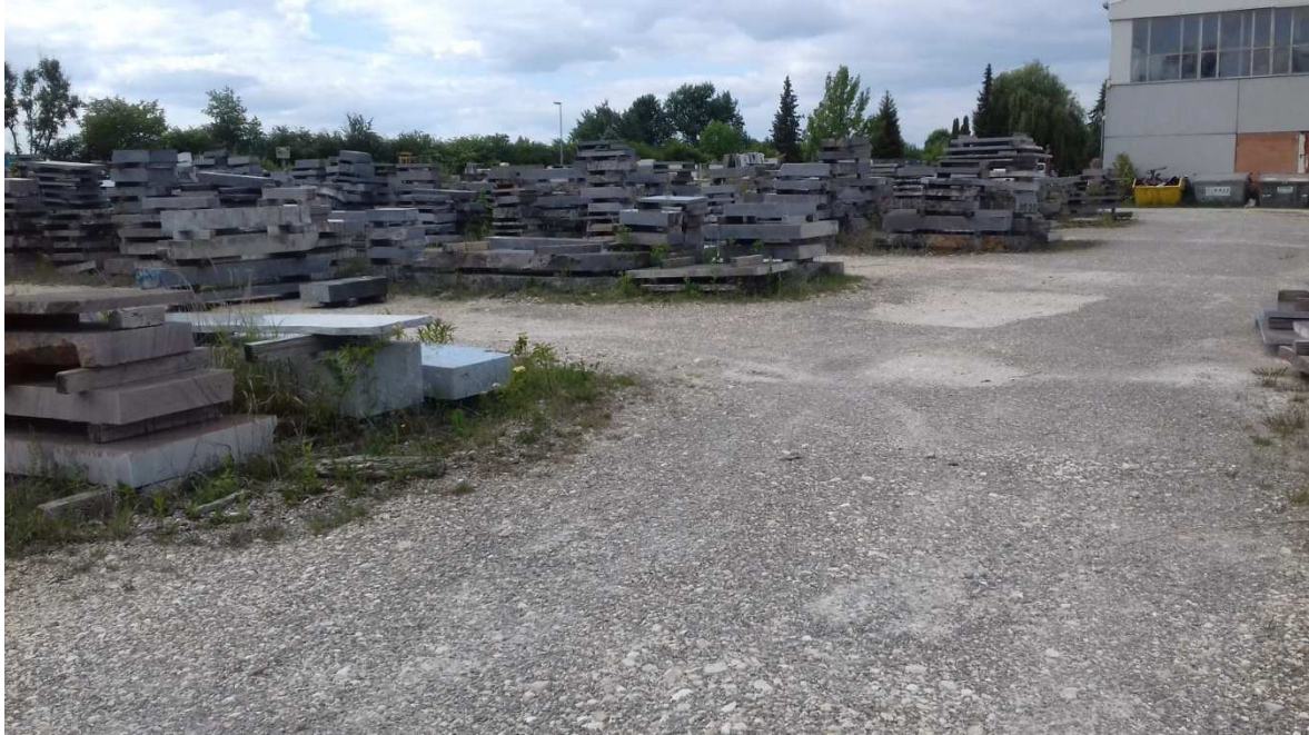
Abb. 3: Betriebsfläche mit geschottertem Untergrund.
