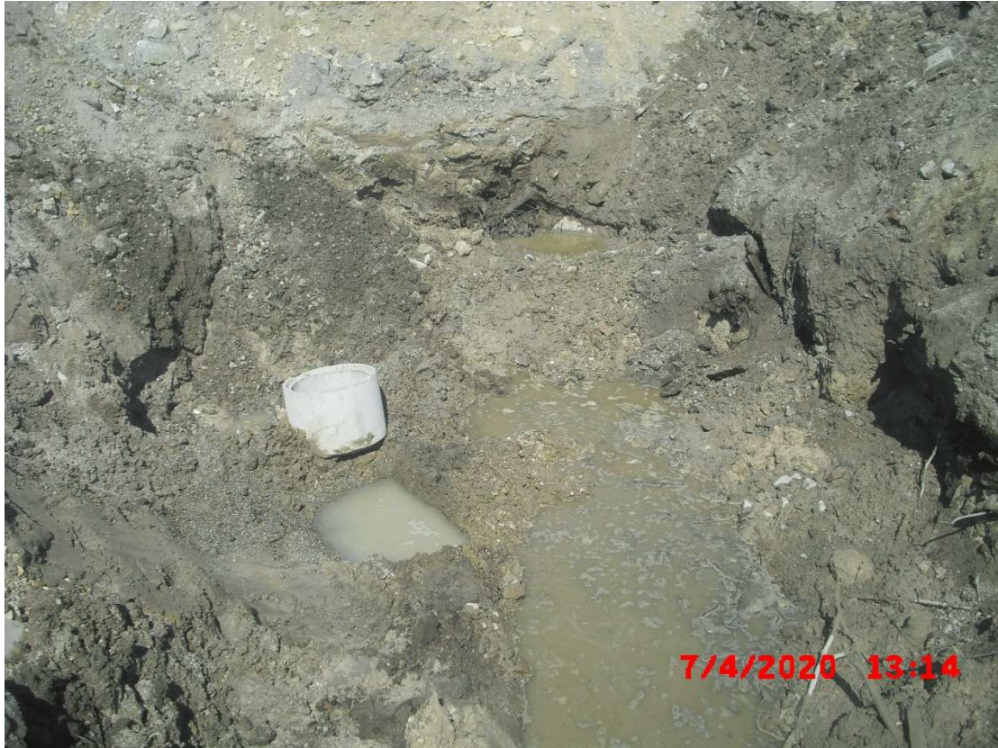
Abb. 13: Sohle der Aushubgrube
