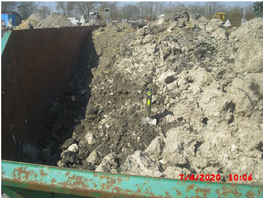
Abb. 14: Aushubmaterial (teerhaltige Lage mit über- bzw. unterlagerndem Schluff) im Container der Fa. Fisel.
