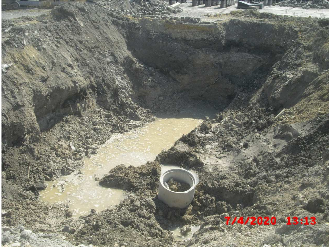
Abb. 11 : Aushubgrube (Blick von Norden) nach dem Ausbau der teerhaltigen Lage. Bei dem dunklen Horizont in der Schurfwandung handelt es sich um einen dunkelbraunen Schluff.
