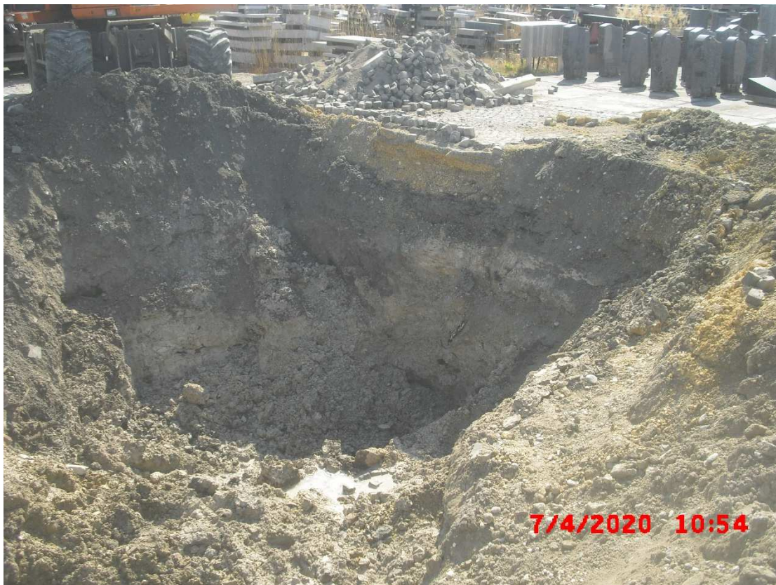
Abb. 8: Südliche Aushubwandung nach dem Erweitern der Grube nach Süden bis zum Ende der teerhaltigen Lage in südliche Richtung
