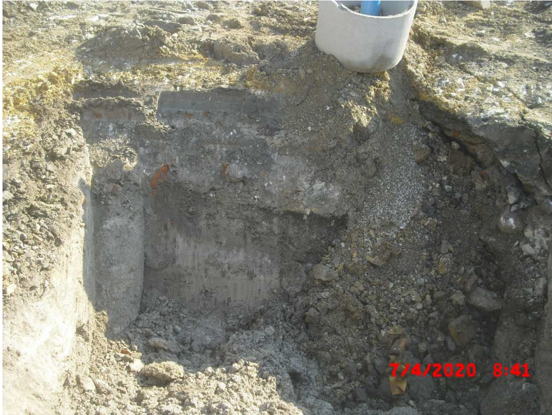
Abb. 1: Aushub im Bereich von Schurf 8, westliche Schurfwandung. In der Bildmitte ist die teerhaltige Lage zu erkennen.
