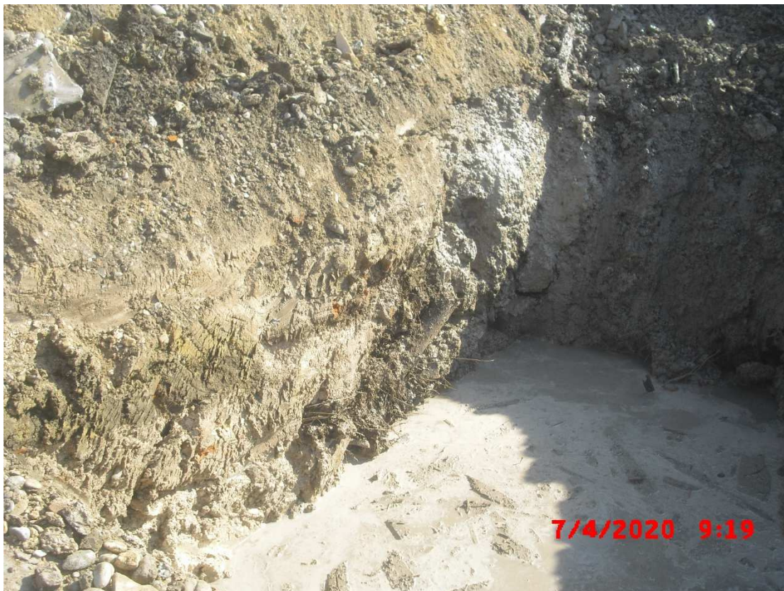
Abb. 2: Aushubgrube, nordöstlicher Bereich. In diesem Bereich wurde die teerhaltige Lage nicht gefunden. Beim Wasser in der Aushubgrube handelt es sich um oberflächennahes Stauwasser.
