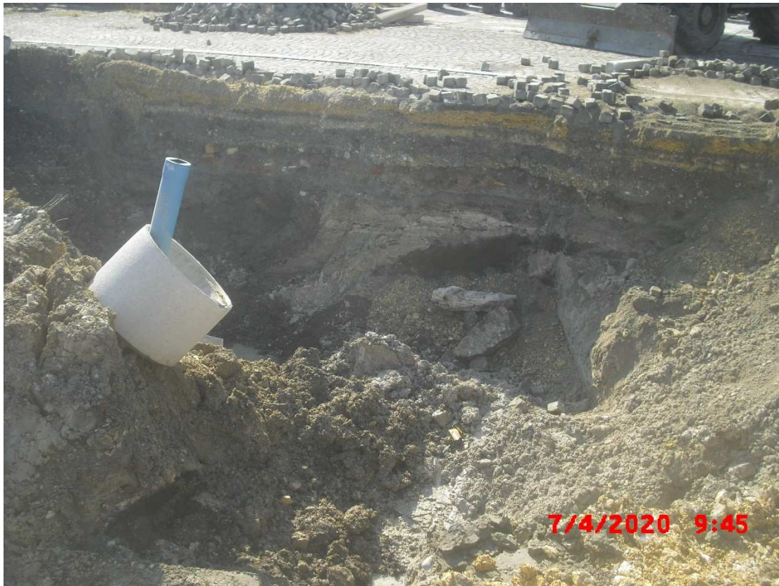
Abb. 5: Südliche Grubenwandung mit der teerhaltigen Lage (Bildmitte). Zum Ausbau der Lage musste die Aushubgrube in südliche Richtung erweitert werden.
