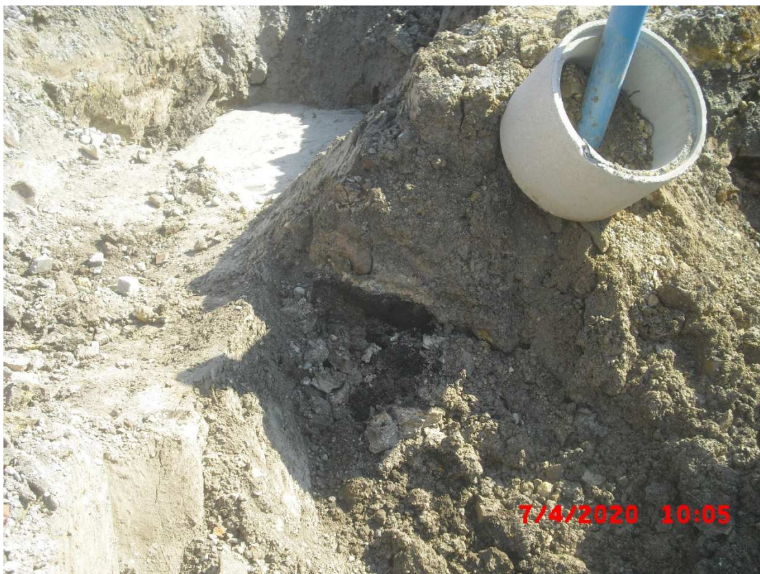
Abb. 6: Teerhaltige Lage im Bereich von Schurf 8, östlicher Schurfbereich
