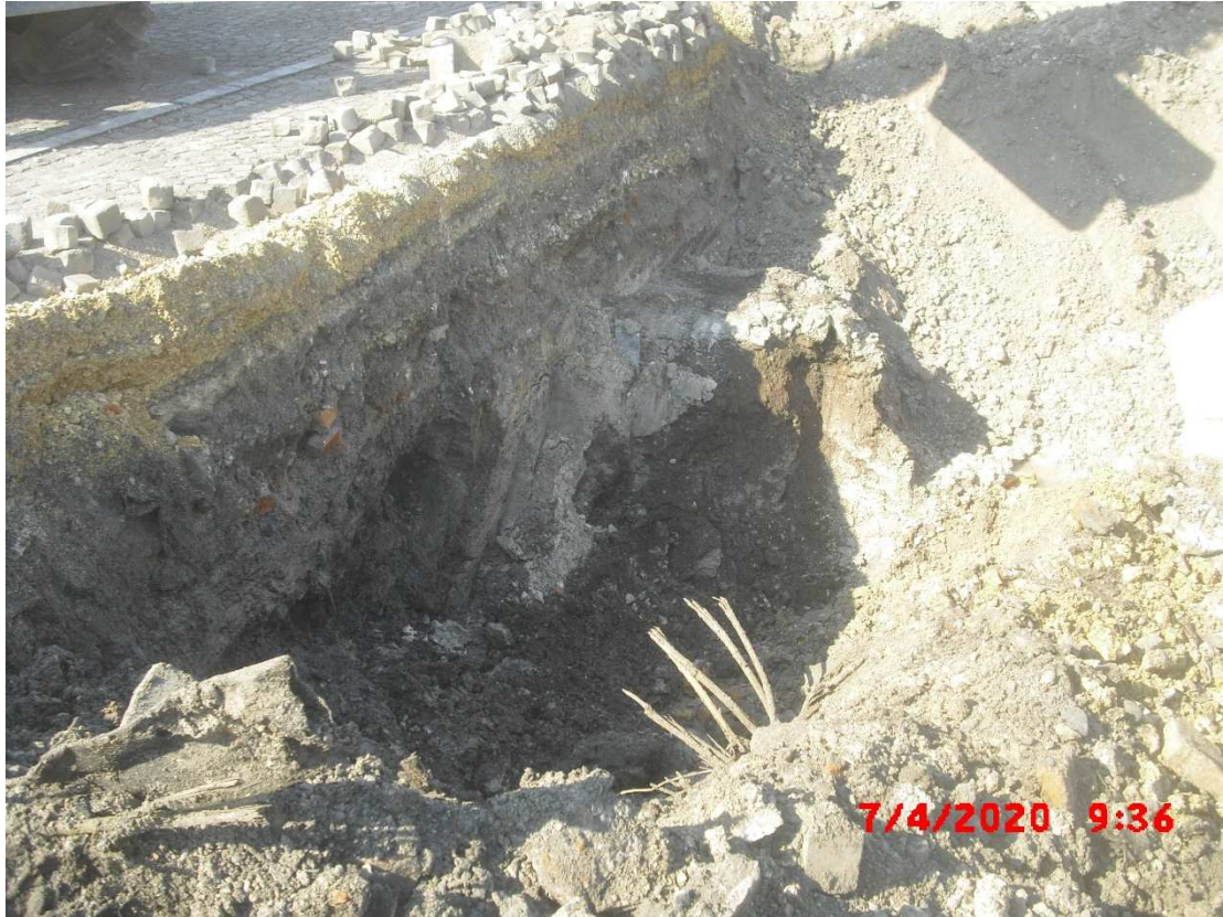
Abb. 3 : Aushubgrube, südwestlicher Bereich. In der Bildmitte ist die teerhaltige Lage in der Grubenwandung erkennbar.
