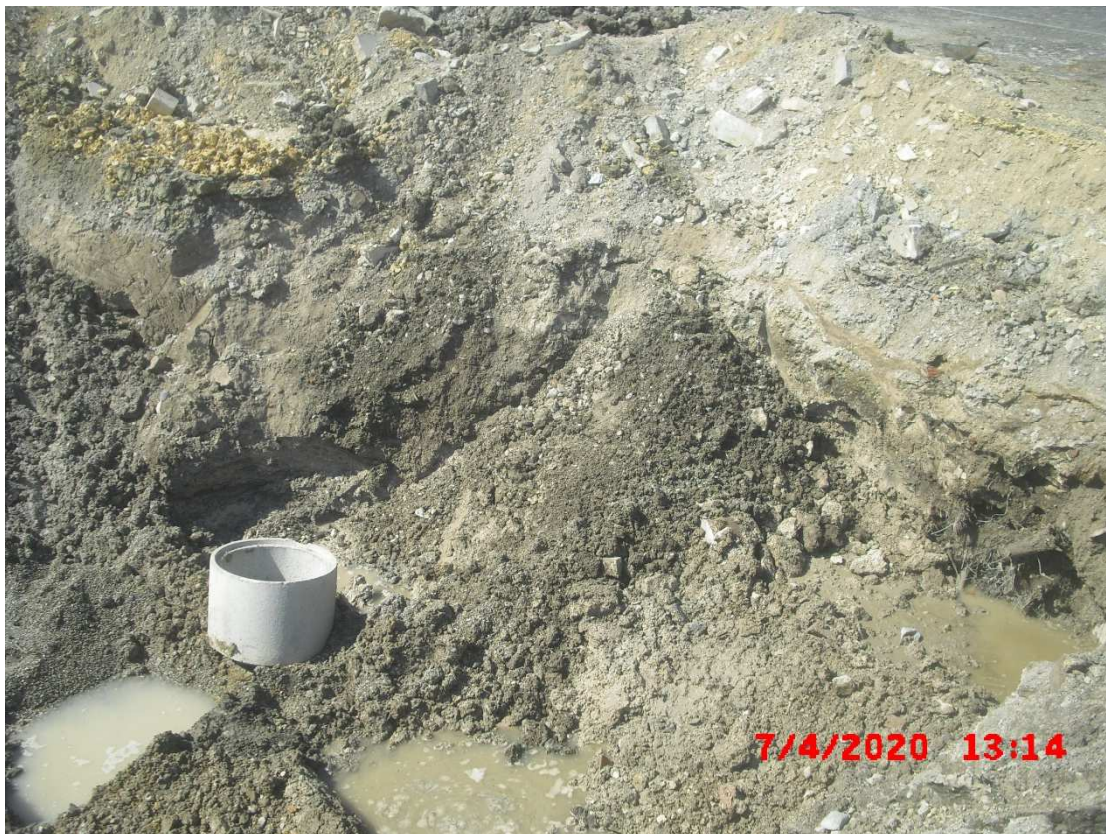
Abb. 12 : Aushubgrube nach dem Ausbau der teerhaltigen Lage, Nordwestbereich
