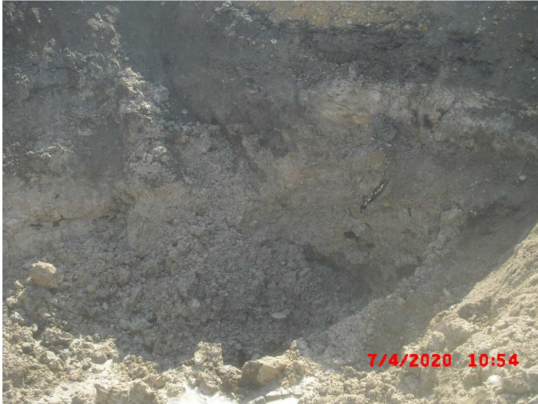
Abb. 9: Südliche Aushubböschung nach dem Ausbau der teerhaltigen Lage.
