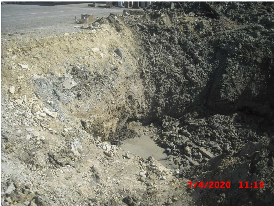
Abb. 10: Nordöstliche Böschung der Aushubgrube
