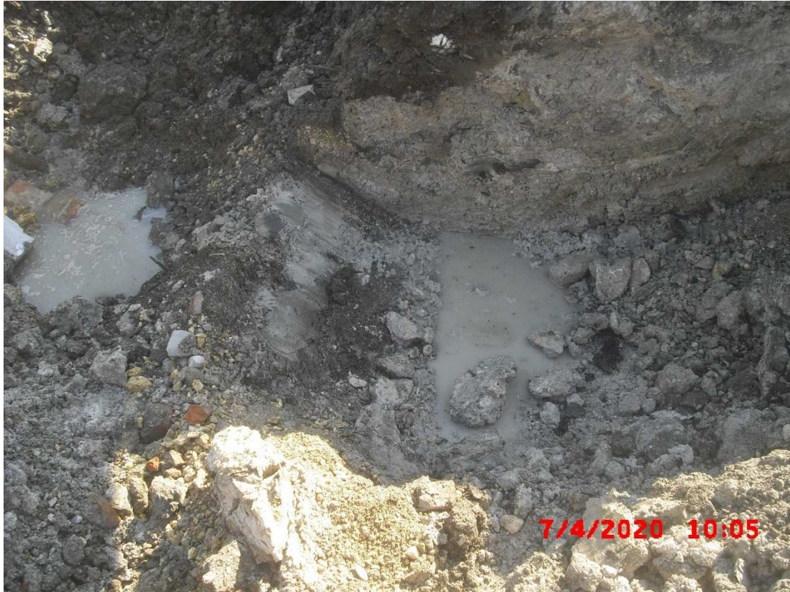
Abb. 7: Unauffälliger, almhaltiger Schluff unterhalb der teerhaltigen Lage im südlichen Aushubbereich.
